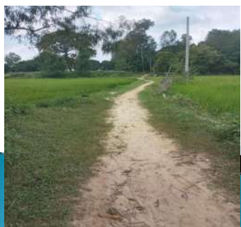
भोली सांखुयाको घर देखि पश्चिम बलान सम्म बाटो निर्माण
